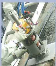
④SAAMジャッキ設置
