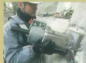
④SAAMジャッキの設置
