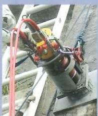
⑥ジャッキホース設置
