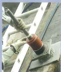
②テンションバー設置
