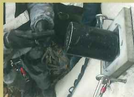
⑥取り外し用ボルトの設置
