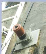
①カプラー設置
