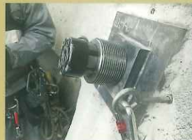
②セッター付きくさびの設置
